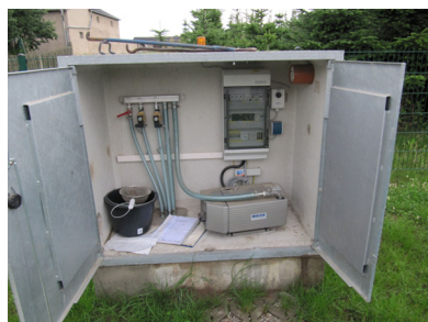
Steuerung einer KKA
