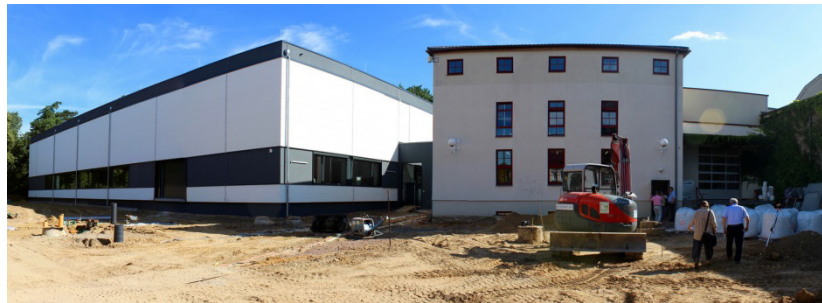
Neubau Werkstätten in Dresden-Cotta; © SRH
