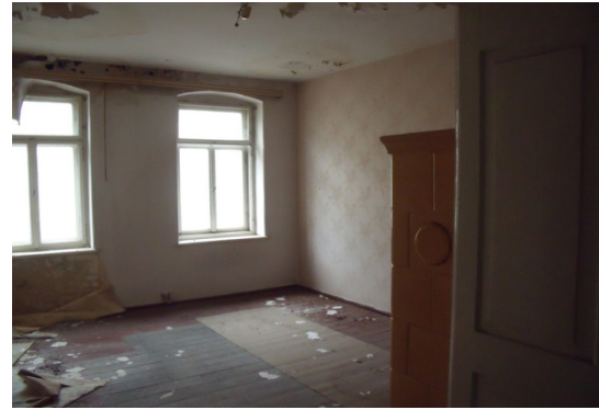
Bild 3: Straßenseitiges Zimmer, südlicher Gebäudeteil
