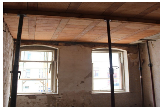
Bild 5: Neu eingebaute Füllkörperdecke über dem Erdgeschoss
