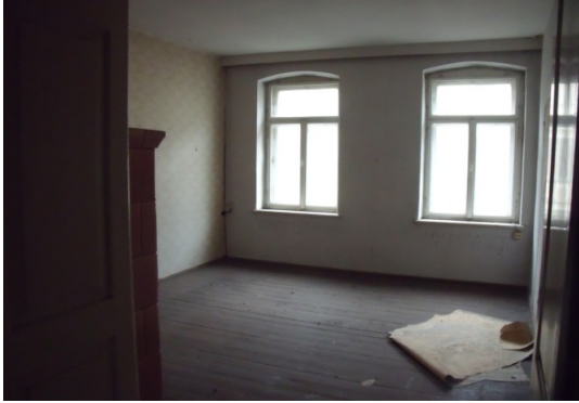
Bild 2: Straßenseitiges Zimmer, nördlicher Gebäudeteil
