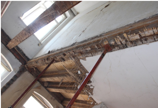
Bild 4: Deckenbalken und -bereiche ohne sichtbare Schäden (mit teilweise entfernten Fehlböden) 1./2. Obergeschoss
