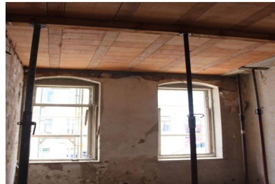
Bild 5: Neu eingebaute Füllkörperdecke über dem Erdgeschoss
