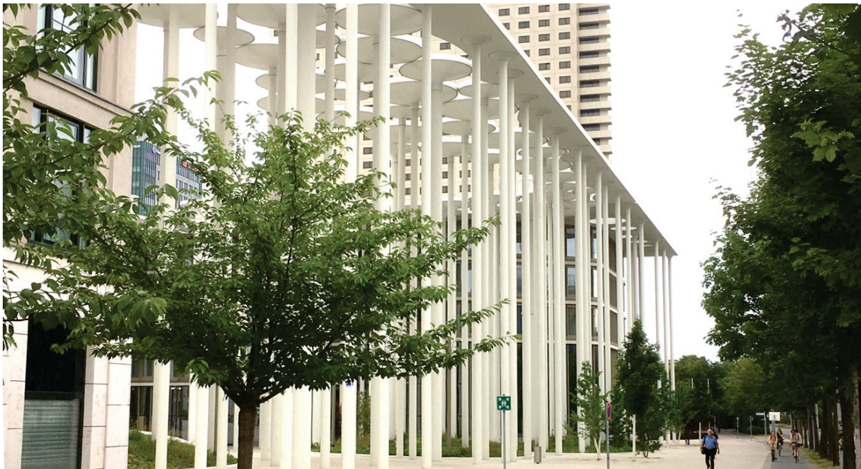
Abbildung: Ansicht von Süd-Ost
